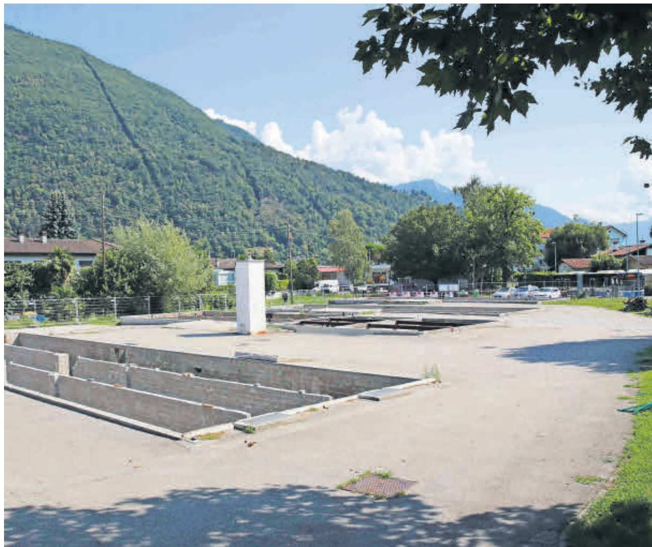
TABULA RASA Dei prefabbricati di via Cesura sono ormai rimaste solamente le fondamenta.
